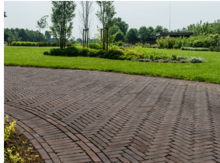
Het lint (primaire infrastructuur) voorzien van rood-paarse bestrating in elleboogverband
